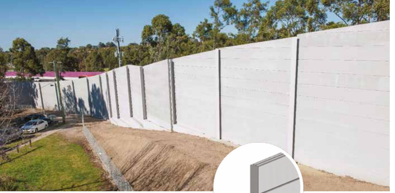
Şekil 3. Ytong panellerin lambazivana profil yapısı
